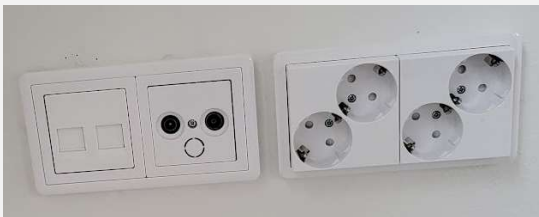
SÄHKÖKALUSTESARJA SCHNEIDER EXXACT TAI VASTAAVA
